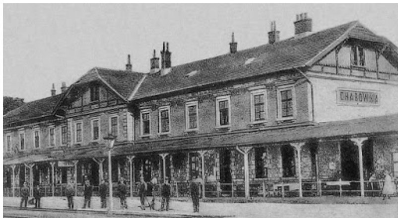
Stacja kolejowa w Chabówce. Fot. ze zbiorów Józefa Szlagi
